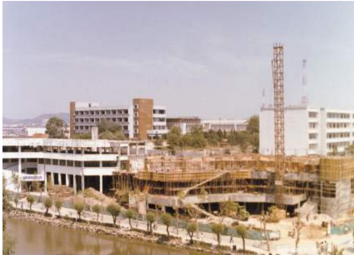
학생회관 개축 공사현장
