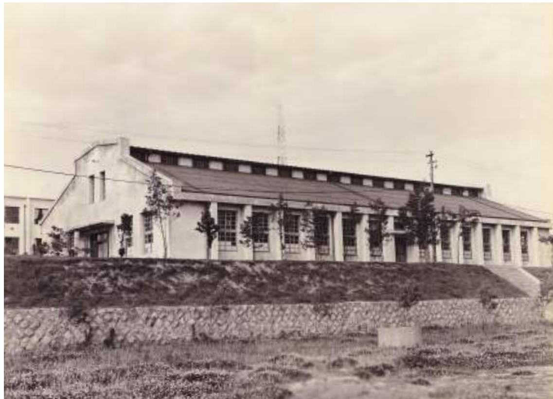
초기교사 B동 (기계공학관 부속공장)
