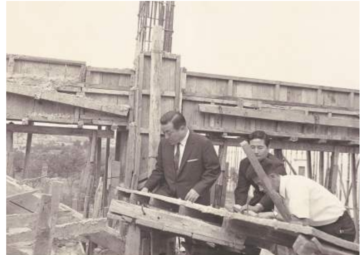
본관 공사현장을 찾은 조중훈 이사장
