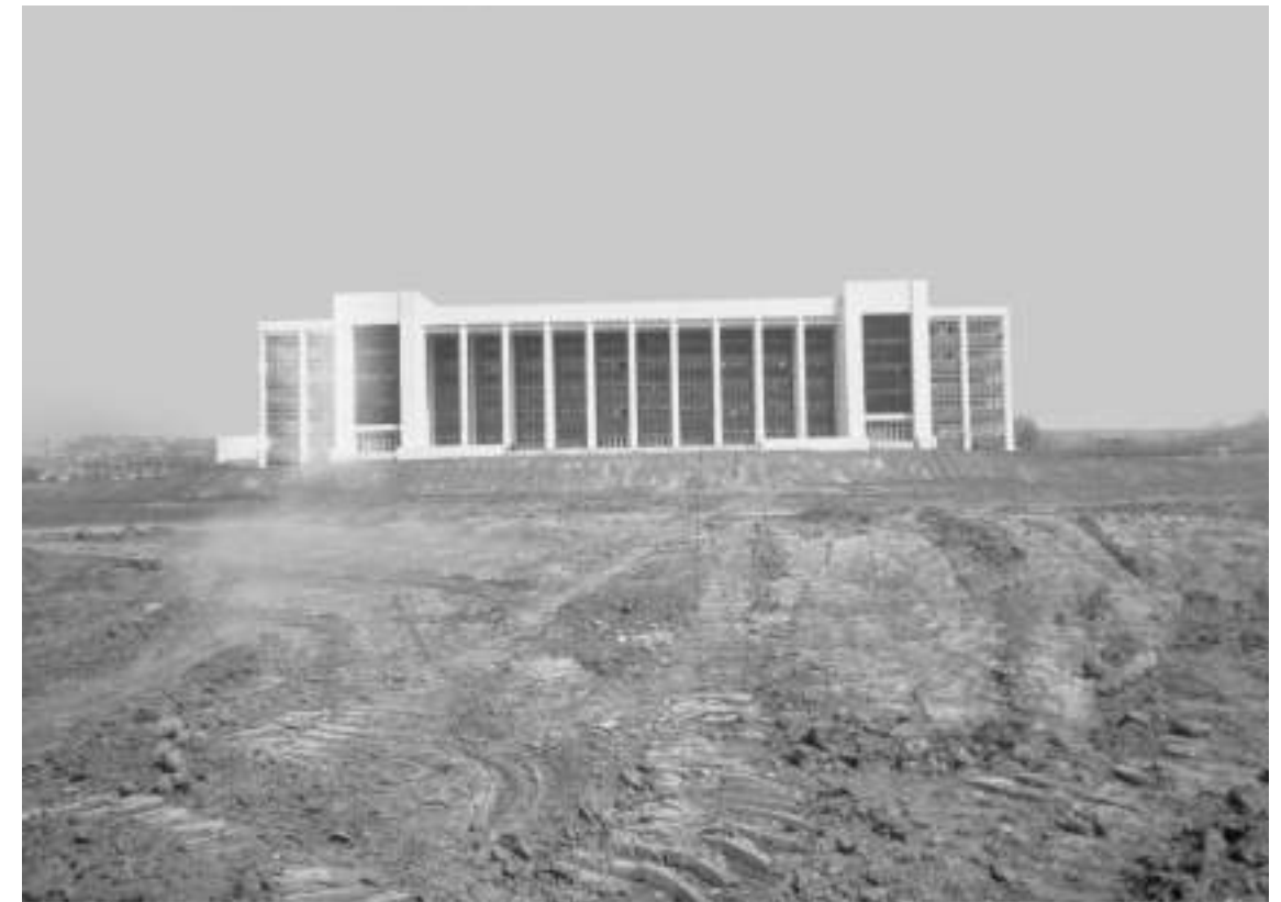
본관 신축후 분수대 주변 공사현장
